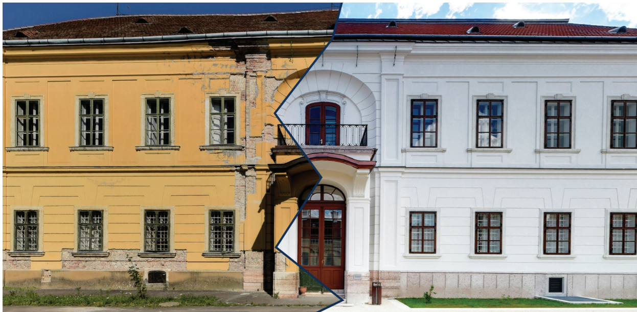
■ A tatai Esterházy-kastély homlokzata felújítás előtt és után
